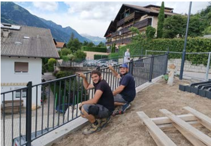
Matthias Mair (Firma Mair Metallbau) und sein Mitarbeiter montieren den neuen Zaun mit schönem Handlauf in der Ifingerstraße.
