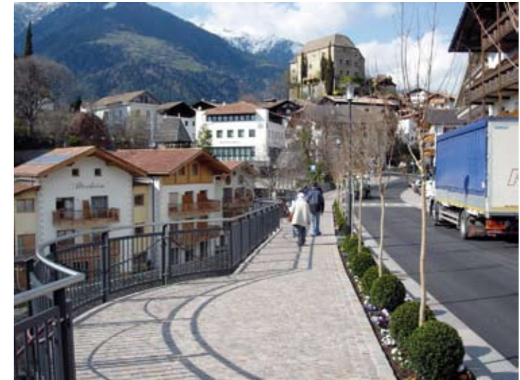
... und nach Abschluss der Bauarbeiten
