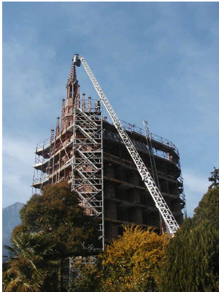
Auf der 30 Meter langen Untermaiser Feuerwehrleiter (Bild unten) brachte ein Feuerwehrmann und Alexander Tscholl (Bild oben) die restaurierte Kreuzblume auf die Spitze des Kirchturms
