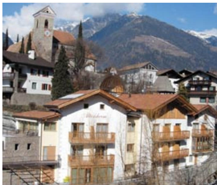
Als schmuckes dreigiebeliges und gut eingerichtetes Gebäude kann das neue Altersheim im Dorfkern von Schenna 21 älteren Menschen Aufnahme bieten
